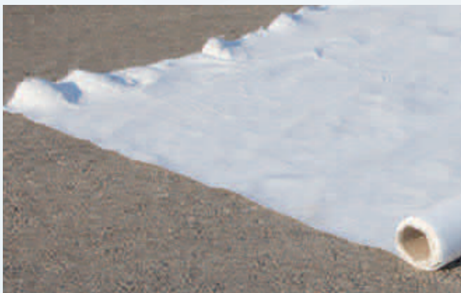
Vliese zum Schutz der Dachabdichtung unter dem Dachsubstrat.
