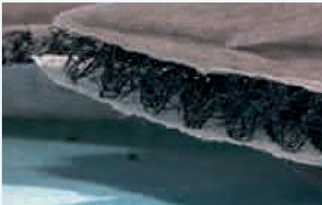
Drainagematten leiten das Wasser zur Dachrinne.
